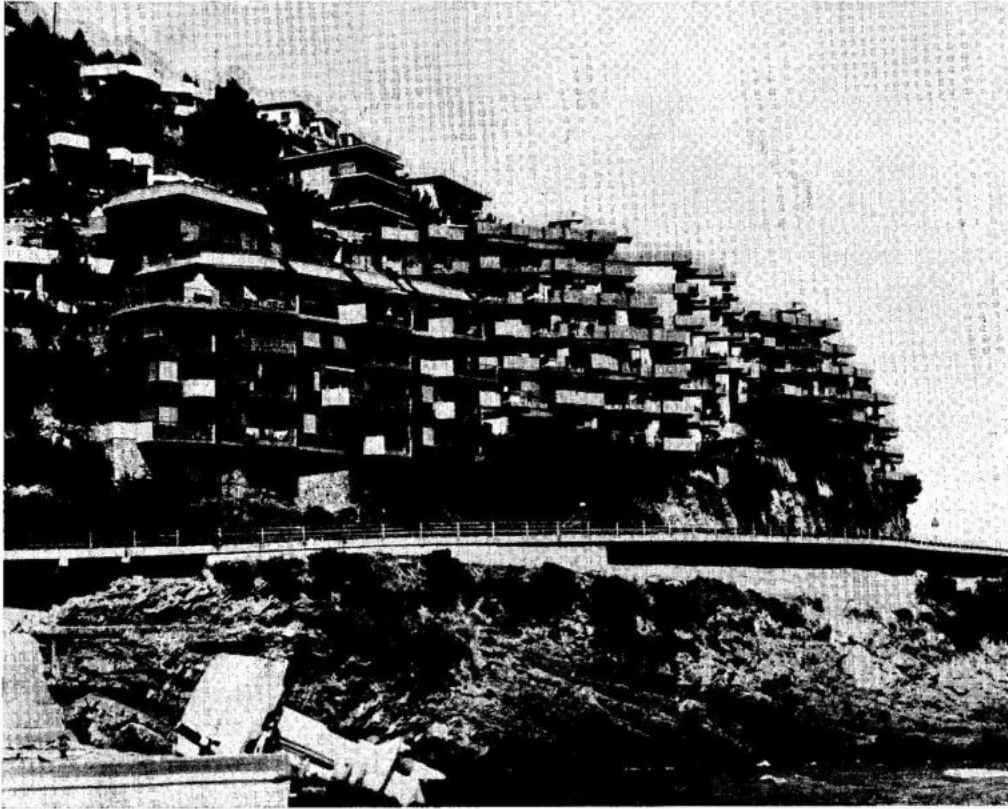
FIG. 4 - Torre del Mare, Savona. (Foto BRAMBILLA da Italia da salvare ).
