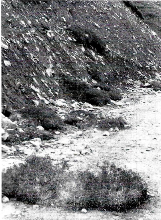
Un esempio di distruzione della natura; il lento lavoro di consolidamento dei detriti, iniziato dalla glaciazione ad oggi, vanificato in pochi giorni dalla ruspa. Ben visibili i lembi di brughiera che scivolano verso il fondo stradale. L'immagine è del 1981; oggi la situazione è ben peggiore...
