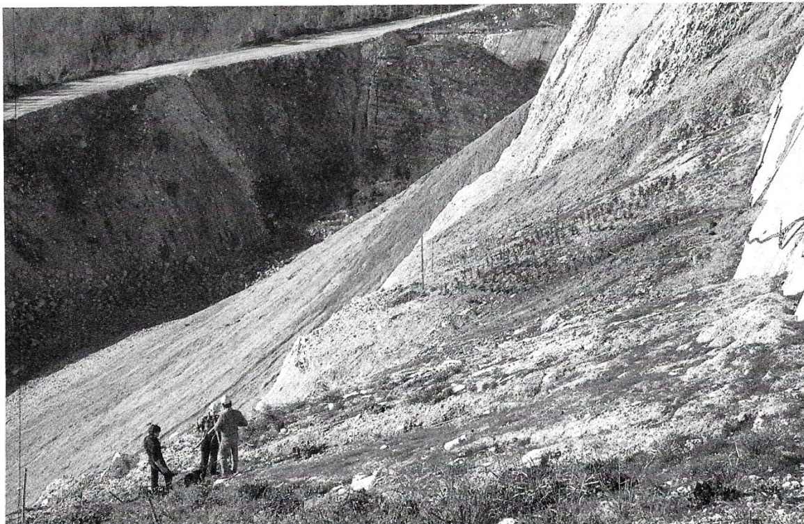
Fig. 4 - Miniera Alpetto (Cesana Brianza, Como): posa di piante cespugliose su un gradone obliquo. (Foto dell'Autore)
