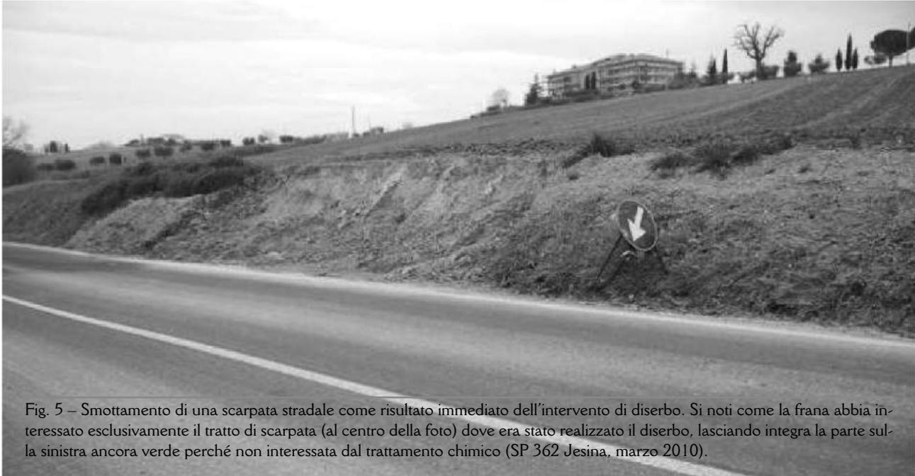
Fig. 5 – Smottamento di una scarpata stradale come risultato immediato dell'intervento di diserbo. Si noti come la frana abbia interessato esclusivamente il tratto di scarpata (al centro della foto) dove era stato realizzato il diserbo, lasciando integra la parte sulla sinistra ancora verde perché non interessata dal trattamento chimico (SP 362 Jesina, marzo 2010).
