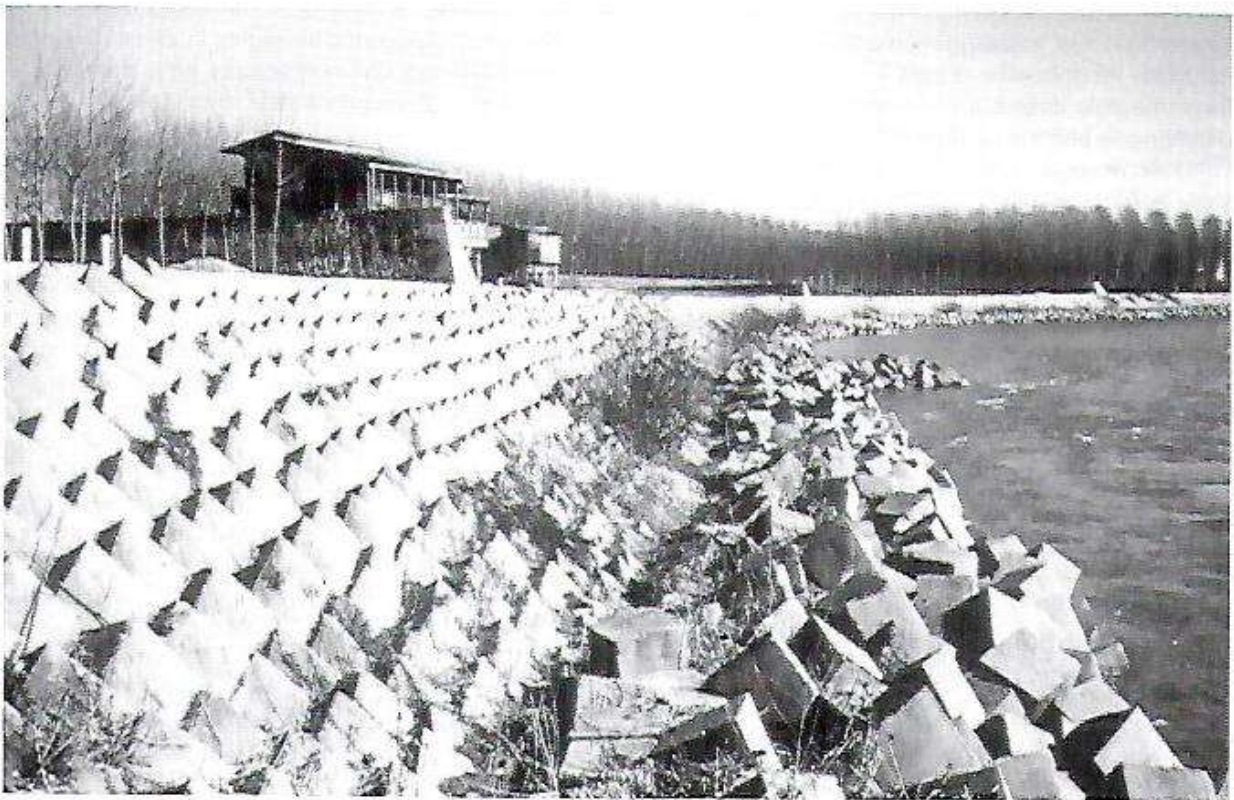
Fig. 1a - Cementificazione delle sponde del Pò: le famigerate primate a Casale Monferrato. Foto del 1985.
