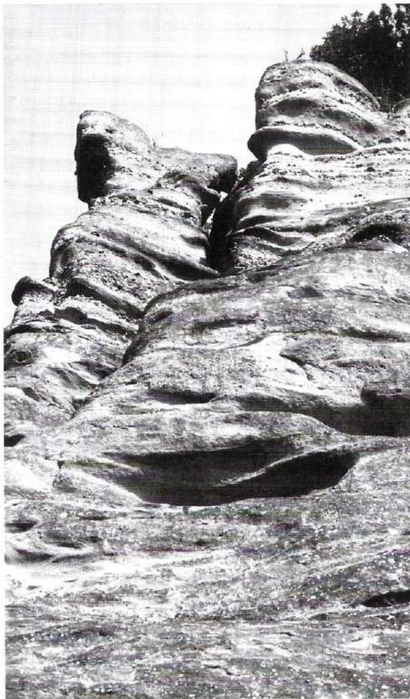
Erosione eolica sulle arenarie del Contrafforte.
