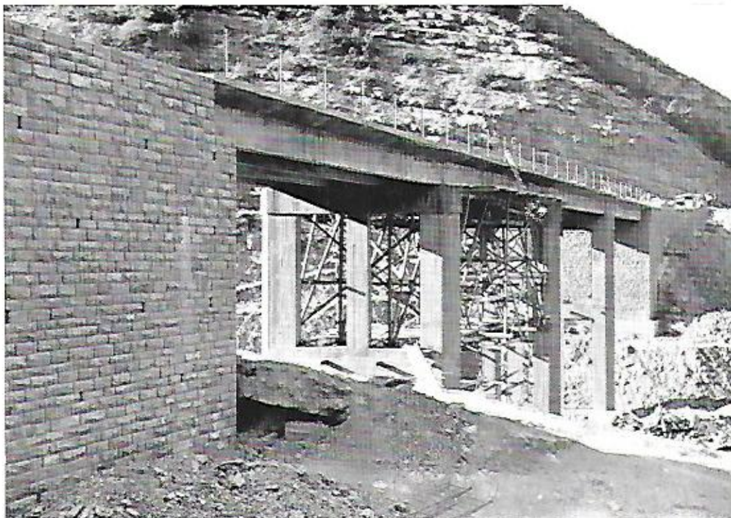
Fig. 7. - Foreste demaniali dell'Alto Forlivese: Costruzione strada per Fiumicello. Ponte sul fiume Rabbi (Premilcuore).
