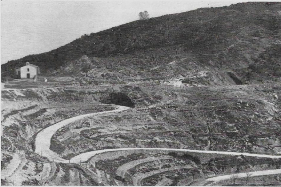
Sistemazione idraulico-forestale del bacino montano del « Cedrino », perimetro del Monte Ortobene: piantagione e semina di resinose su terreno sistemato a gradoni nella zona prospiciente la Chiesetta della Solitudine. Si noti l'aspetto desolante che offriva la zona prima di essere sottoposta a valorizzazione.
