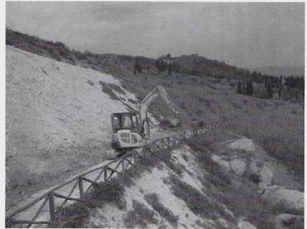
Fig. 10 – Il mezzo usato per la ripulitura del piede della scarpatina. Sotto la staccionata la vegetazione pioniera sta nascondendo alla vista la Formazione a Colombacci e la superfice sommitale erosiva e paleocarsica delle bancate gessose.
