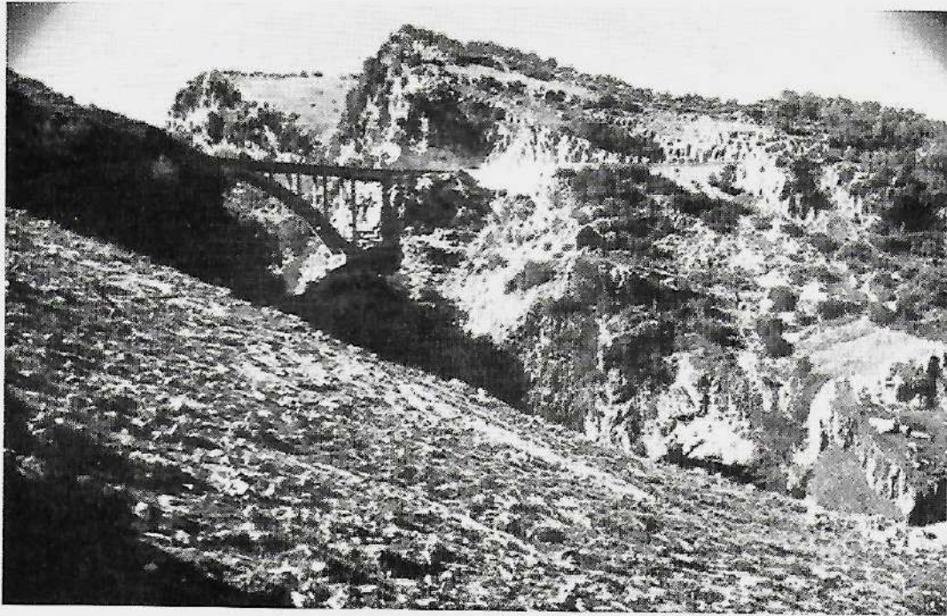
Fig. 4. - Il ponte dell'Arcicchiario all'imboccatura della gola del torrente Quirino (dove è previsto lo sbarramento per il primo serbatoio).
