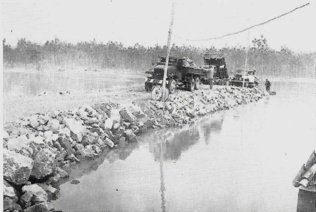
Fig. 8. - Rotta del Po di Goro a Torre di Rivà. Costruzione di una coronella in ritiro per arginare il deflusso a campagna delle acque di piena. Lunghezza m. 230-240 circa (nov. 1960).
