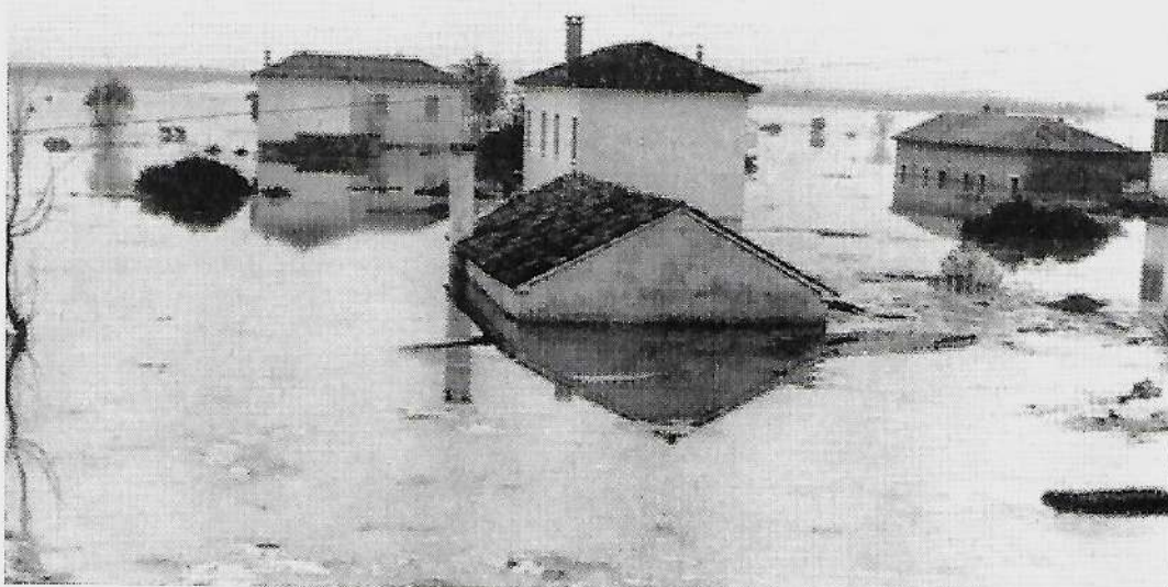
Fig. 3. - Zona di allagamento di una rotta del Po di Goro (nov. 1960).
