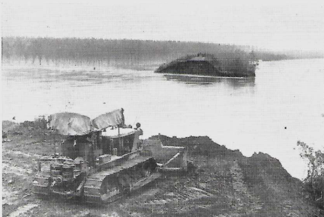
Fig. 7. - Rottura dell'argine del Po di Goro a Torre di Rivà. Estesa della breccia 130 ÷ 140 m. circa; portata massima 500 ÷ 600 mc/sec. (nov. 1960).
