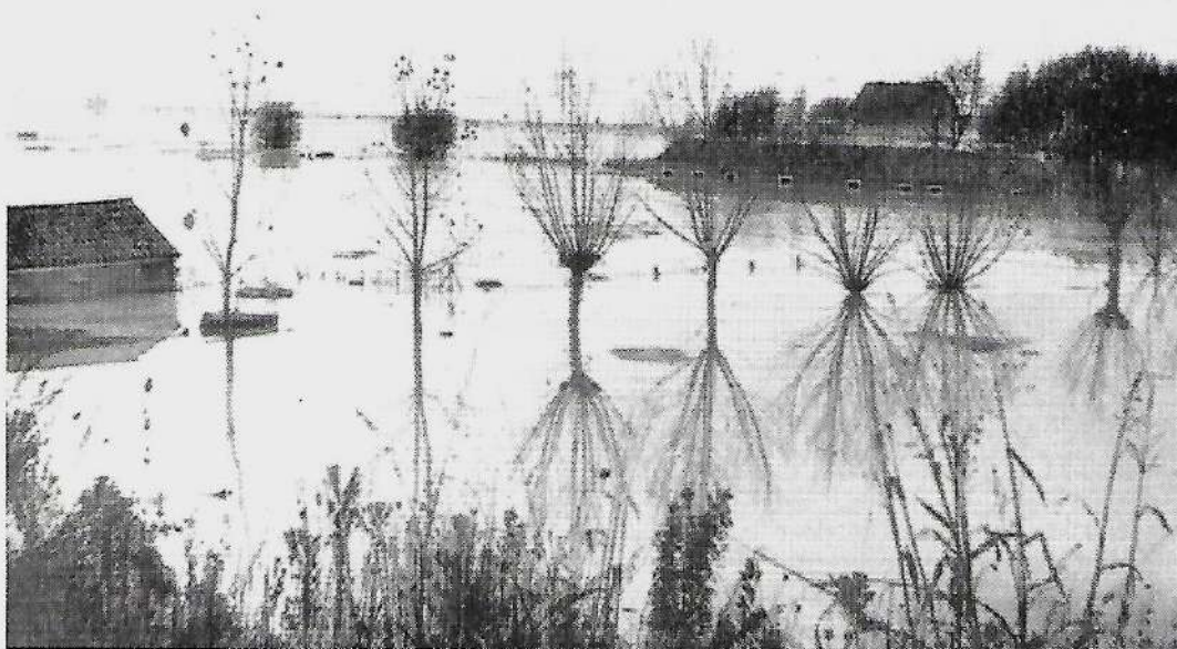
Fig. 2. - Zona di allagamento di una rotta del Po di Goro (nov. 1960).
