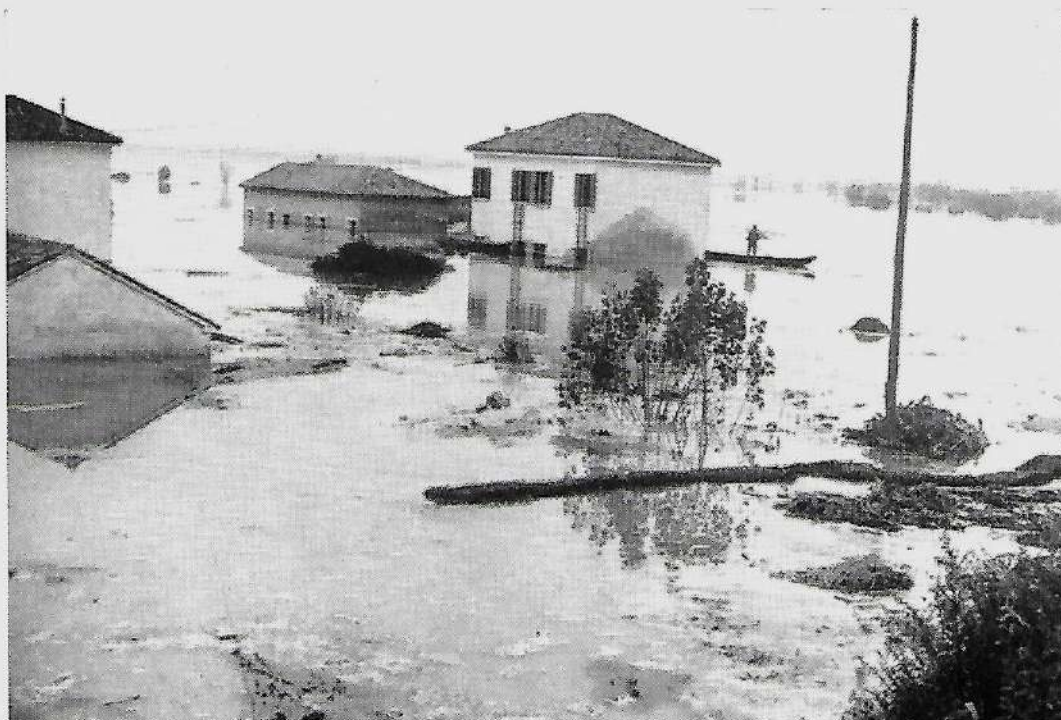
Fig. 4. - Zona di allagamento di una rotta del Po di Goro (nov. 1960).
