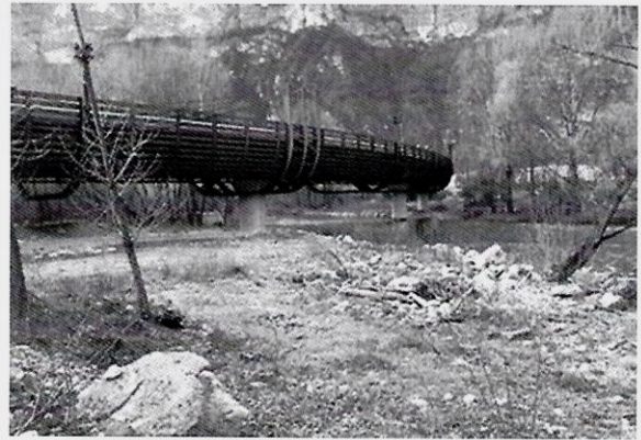
Fig. 2 – Il nuovo ponte che spacca in due il biotopo protetto La Rupe, Mezzolombardo; il biotopo è stato istituito dalla Provincia autonoma di Trento per la tutela della vegetazione ripariale (pioppi e salici) e di una popolazione di ululone a ventre giallo ( Bombina variegata ); ironia della sorte, il ponte è stato chiamato "ponte dell'ululone".
