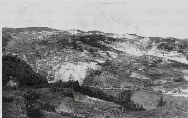
La zona della frana vista dall'opposto versante. Si distinguono facilmente il margine di distacco e le superfici di scivolamento. In secondo piano la chiesa, rimasta intatta al limite del movimento franoso, e, in basso, il lago.
