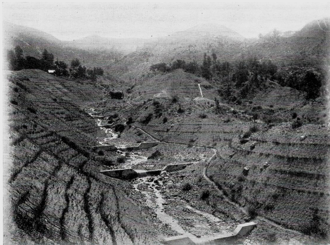
Fig. 2. - Piacenza - Opere di difesa in alveo e sistemazione di sponde in destra del fiume Trebbia.
