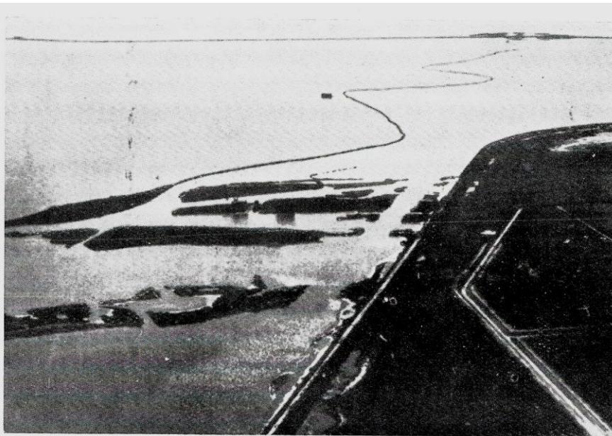
Fig. 5. - Veduta panoramica dell'argine di Agosta (1957).
