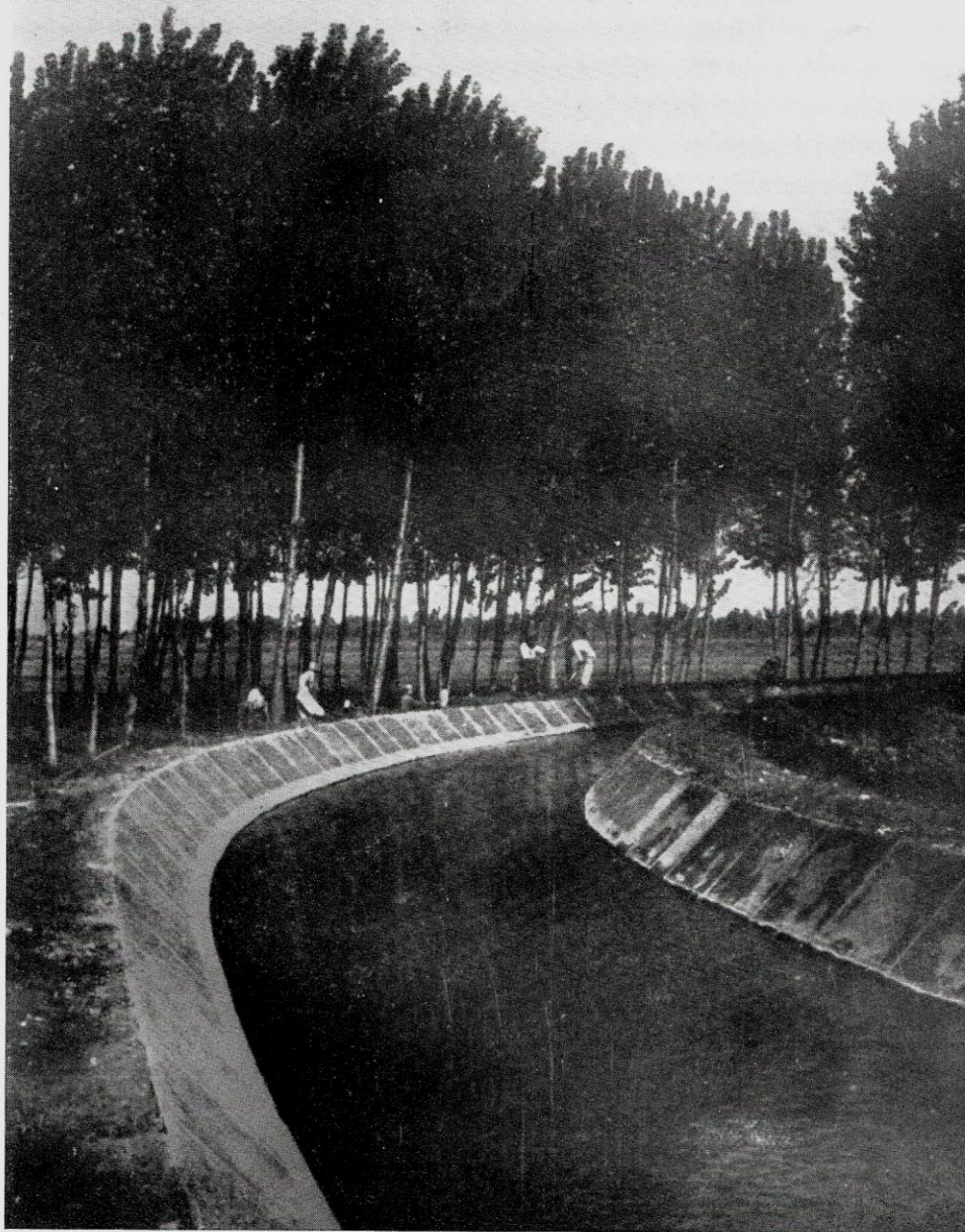
Fig. 3. - Un canale (rivestito in cemento) per l'irrigazione del comprensorio della Grande Bonifica Ferrarese.
