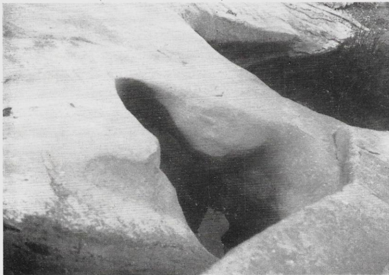
Fosso Molinello - Entrata dell'acqua nella galleria trapanata nelle arenarie compatte.
