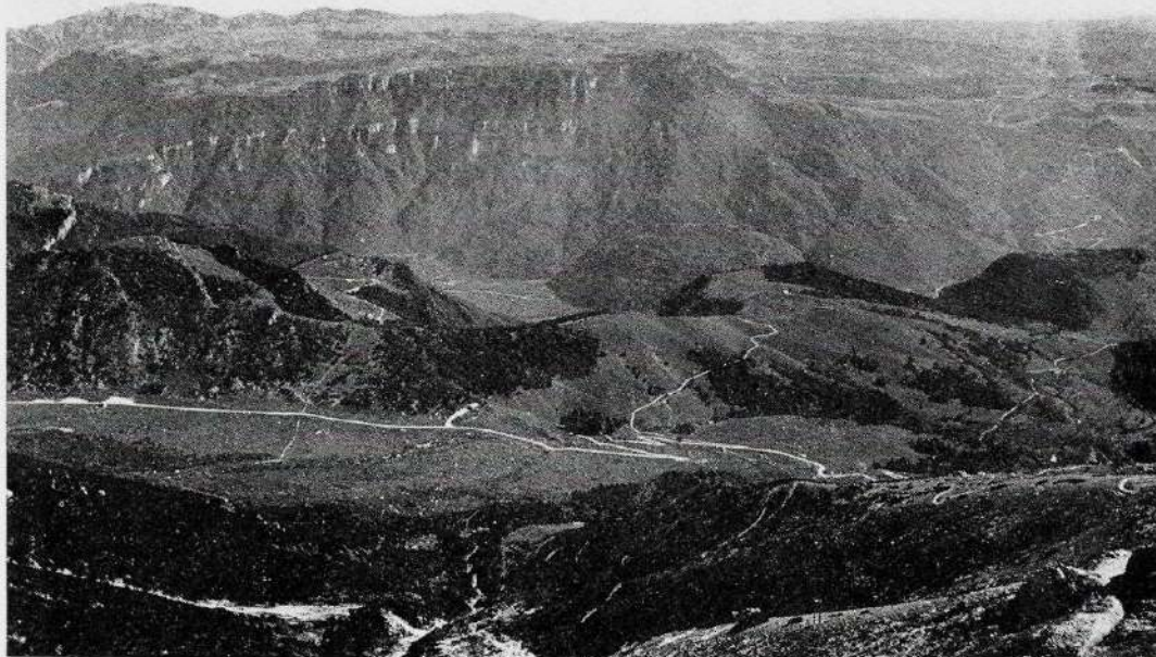
2) L'altopiano dei Lessini visto dal M. Baldo. Si osservi la dolce ondulazione dell'altopiano sommitale e la fessura che lo delimita a sud. Più lontano a sinistra si intravede il Massiccio del Carega. (Foto U. Sauro)
