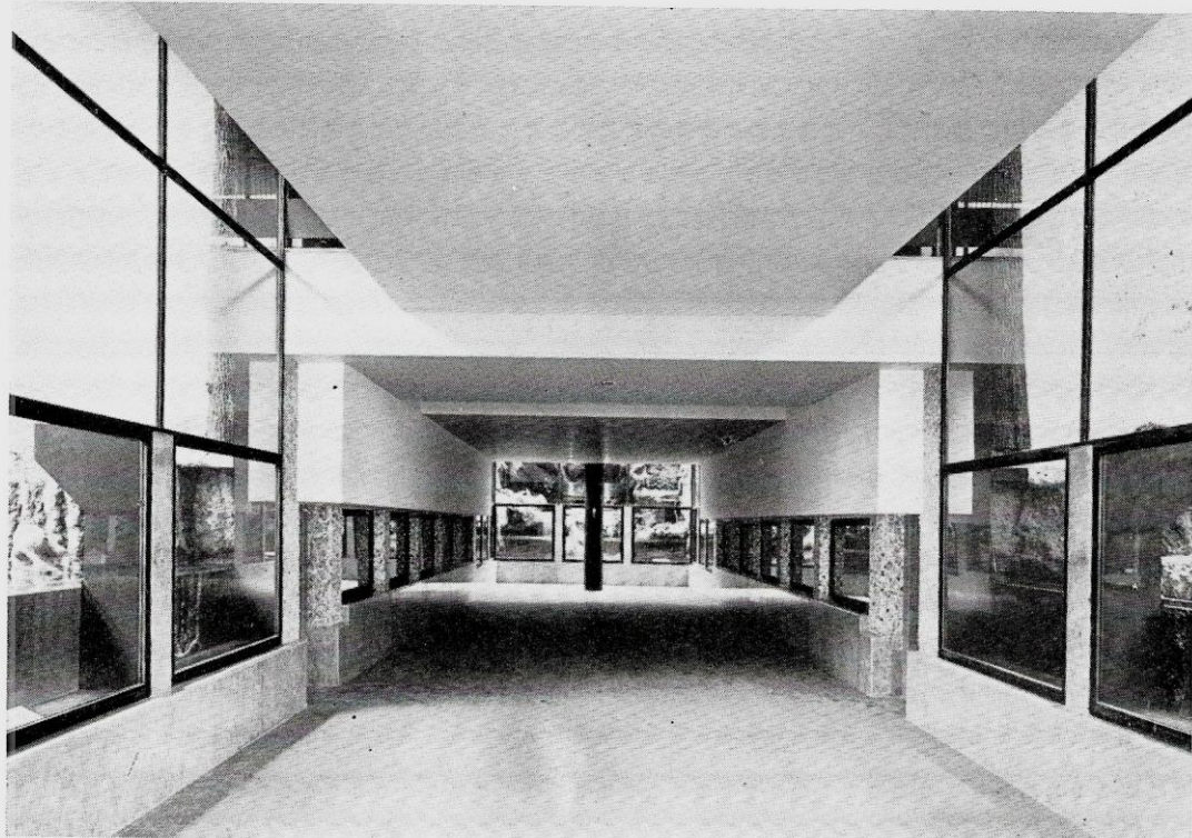
Acquario-rettilario di Torino. Vista del piano acquario: n. 2 camere biologiche Indonesia e Amazzonia; n. 10 vasche acquari; al fondo: n. 2 camere biologiche: Africa e Mediterraneo. Terminale la camera biologica delle trotte.
