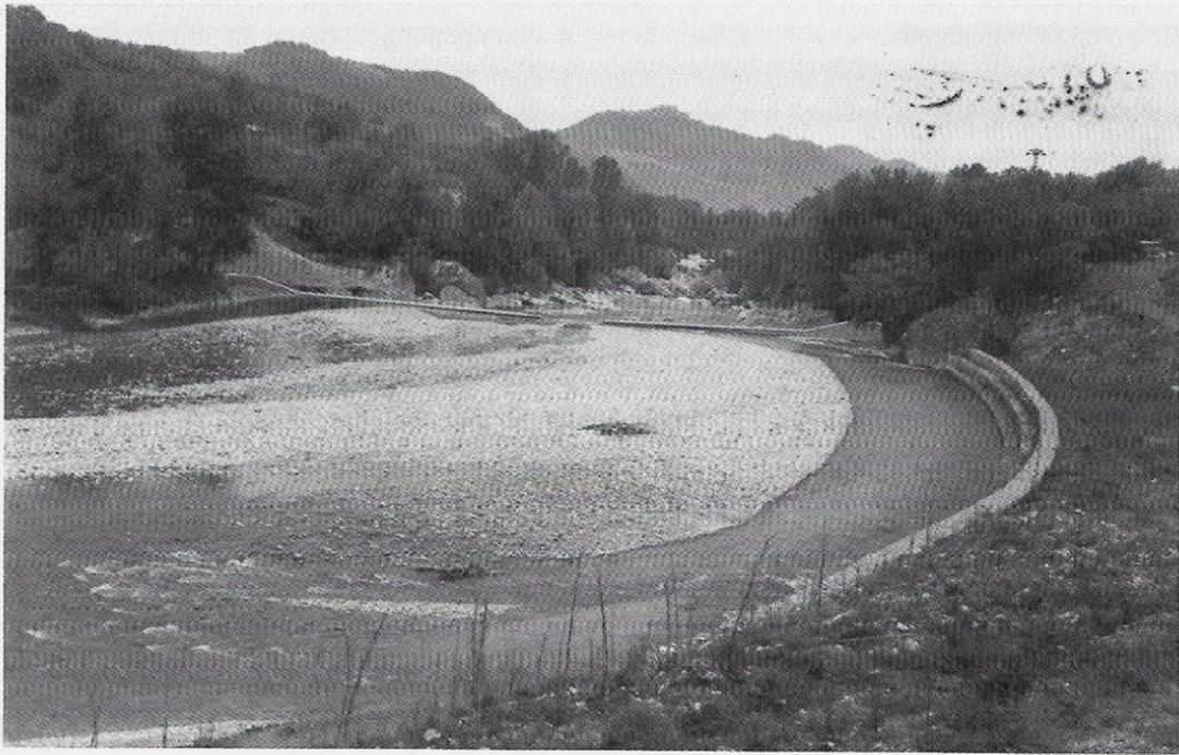
*foto 6 - Ponte Maria Maddalena. Lavori di sistemazione dell'alveo del Marecchia con costruzione di argini e briglie. Sullo sfondo l'aspetto originario dell'alveo.*
