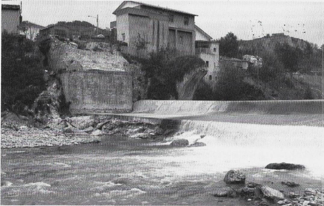
*foto 4 - Ponte Verucchio. Si osservi come la spalla del vecchio ponte distrutto sia impostata ad una quota molto più alta rispetto all'attuale alveo. In primo piano una briglia di recente costruzione.*
