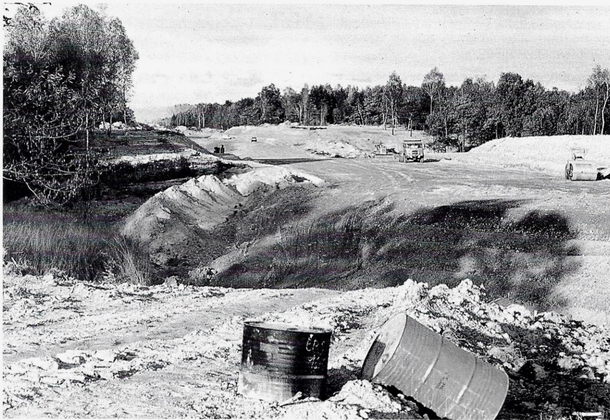
Lavori di costruzione della autostrada Voltri-Sempione attraverso il Piano Rosa (novembre 1985).
