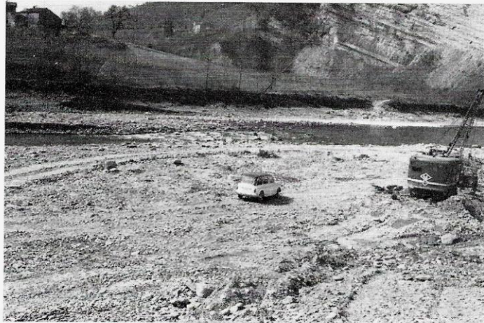
Fig. 5 - Escavazione industriale di ghiaie dal letto del fiume Santerno, nei pressi di Borgo Tossignano. Si noti che un primo strato di ghiaia di 2,5-3 m era già stato scavato in precedenza lungo la riva destra del fiume (la fascia orizzontale più scura, il cui margine superiore rappresentava all'incirca l'originario livello del fiume). (Foto G. B. Vai, 1967)
