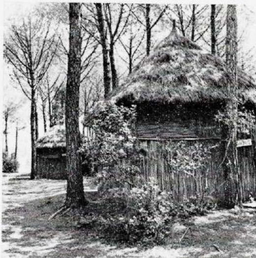
9-10) Piccoli bungalow costruiti all'interno di pinete litoranee e muniti di tetto in E. scoparia . Questo materiale si è dimostrato molto idoneo, come copertura, nel proteggere dalle piogge e dal calore esterno e anche nell'impedire la nidificazione di topi e di altri parassiti delle abitazioni domestiche. In simili circostanze l'uso dell' E. scoparia può rappresentare una soluzione accettabile che non deturpa l'assetto del paesaggio naturalistico.
