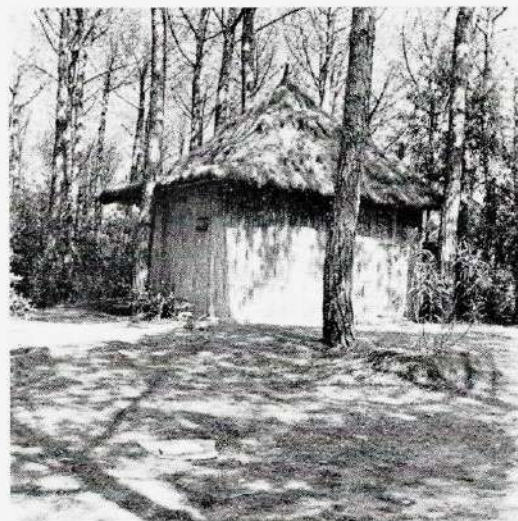
9-10) Piccoli bungalow costruiti all'interno di pinete litoranee e muniti di tetto in E. scoparia . Questo materiale si è dimostrato molto idoneo, come copertura, nel proteggere dalle piogge e dal calore esterno e anche nell'impedire la nidificazione di topi e di altri parassiti delle abitazioni domestiche. In simili circostanze l'uso dell' E. scoparia può rappresentare una soluzione accettabile che non deturpa l'assetto del paesaggio naturalistico.
