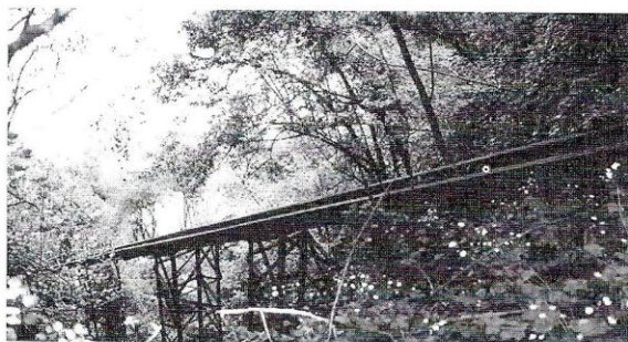
Fig. 14 - Le rotaie realizzate dall'ACEA per il trasporto delle attrezzature (Foto M. Giardini).
