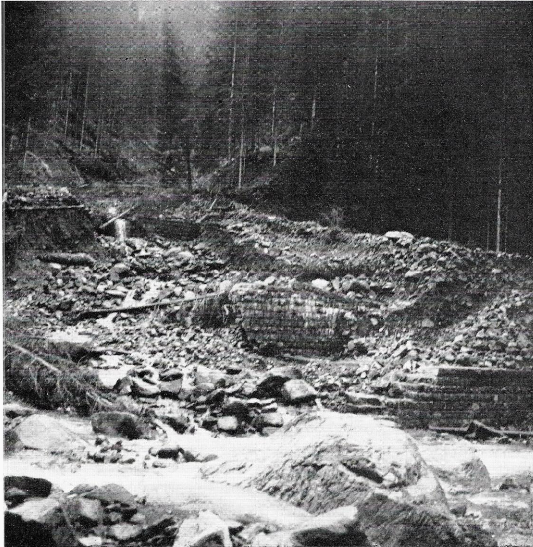
Erosione di sponda, crollo di traverse e deposito di materiali litoidi lungo un torrente alpino durante la piena del novembre 1966.
