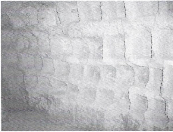
Fig. 16 – Nicchie scavate nella parete rocciosa.
