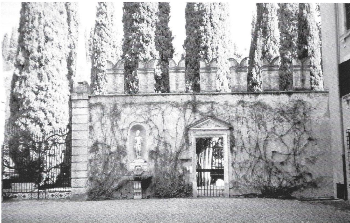
Fig. 1 – Muro merlato del cortile d'accesso al Giardino.
