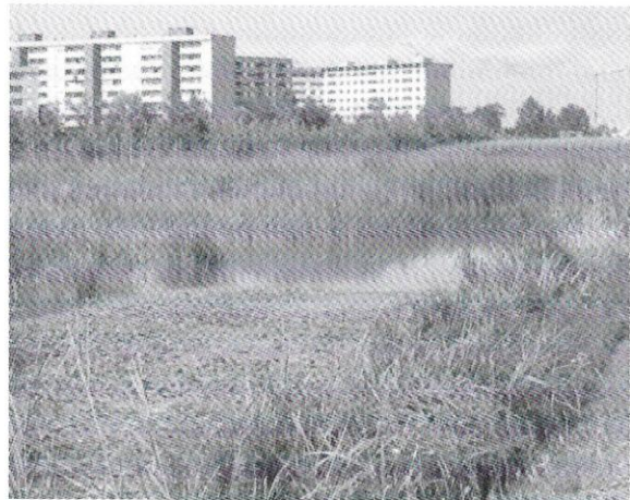
Fig. 7 – Zona umida in alveo creata ampliando la sezione del canale precedente e diversificando opportunamente i profili longitudinali e trasversali. (Consorzio di bonifica Acque Risorgive).
