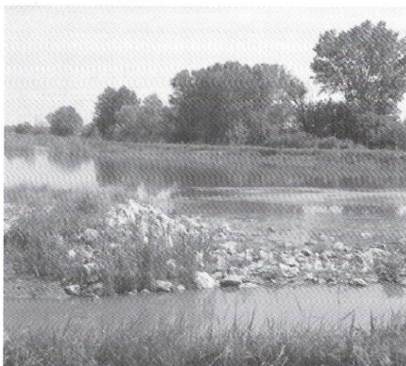
Fig. 2 – Cassa di espansione a servizio del Canale Lorgana (Malalbergo, Bologna). L'intervento insiste su un'area di 6,7 ettari, posta immediatamente a sud dell'abitato di Malalbergo e nettamente delimitata da canali e strutture viarie. La foto mostra un particolare della zona umida: in primo piano il fosso di collegamento tra i canali Lorgana e Botte. Sullo sfondo si notano gruppi di alberi parzialmente sommersi e l'argine perimetrale della cassa (Consorzio della bonifica Renana).
