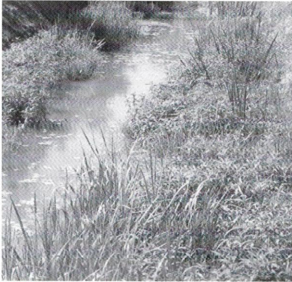
Fig. 9 – Modalità di gestione della vegetazione in alveo funzionale a massimizzare i processi auto depurativi. La vegetazione acquatica non è asportata totalmente, ma sono lasciate due strisce vegetate al piede della sponda. In questo modo le acque del canale possono attraversare, con velocità limitata il sistema fitodepurante naturale e subirne i processi depurativi. (Consorzio di bonifica Acque Risorgive).
