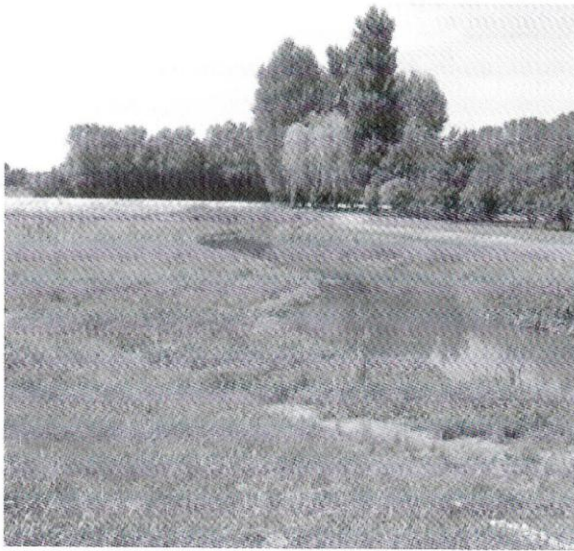
Fig. 5 – Canale rettilineo trasformato in un corso d'acqua sinuoso dotato di area golenale allagabile. (Consorzio di bonifica Acque Risorgive).
