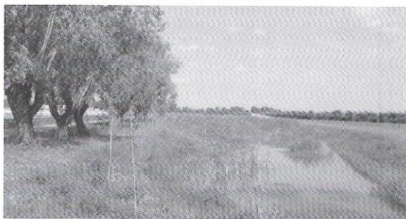
Fig. 1 – Creazione ex novo di un canale naturaliforme su terreno agricolo come si presenta l'anno successivo all'esecuzione dei lavori. Si noti come la vegetazione abbia velocemente colonizzato il canale, progettato per poterla accogliere senza problemi idraulici, finché la densità non supera una soglia predeterminata. La gestione della vegetazione prevede di mantenere aperto un canale di corrente in cui il flusso delle acque può scorrere liberamente (a destra nella foto); la manutenzione avviene solo dalla sponda a destra nella foto resa percorribile per il passaggio dei mezzi del Consorzio (Consorzio di bonifica Acque Risorgive)
