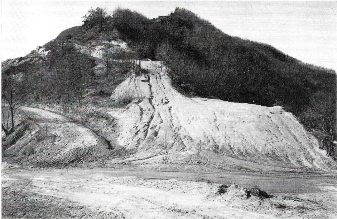
Un incrocio di «strade» di lottizzazione malamente tracciate con la ruspa e in stato di abbandono. Il terreno sciolto di queste zone facilita poi il ruscellamento.
