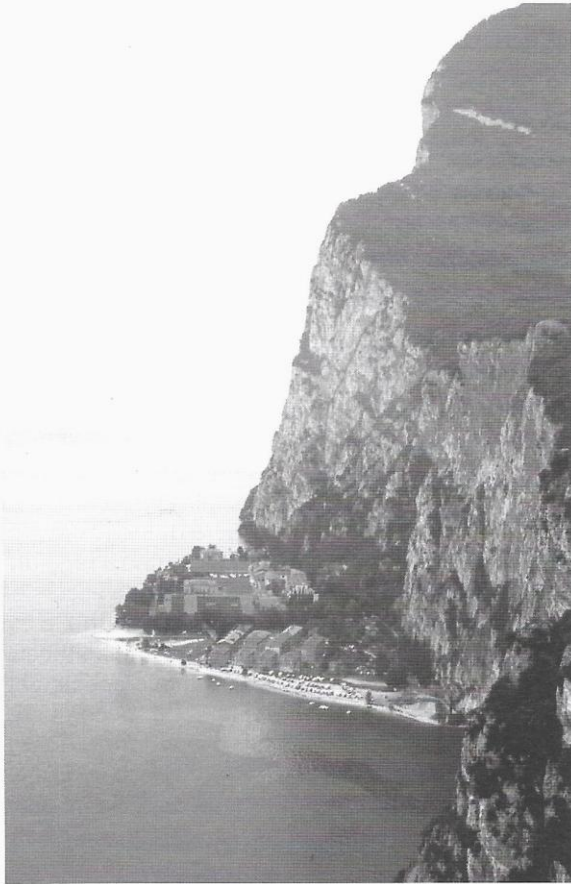
Fig. 21 – Veduta del piccolo insediamento industriale di Campione, situato sul conoide del torrente San Michele e sovrastato dalla mole del Monte Cas.
