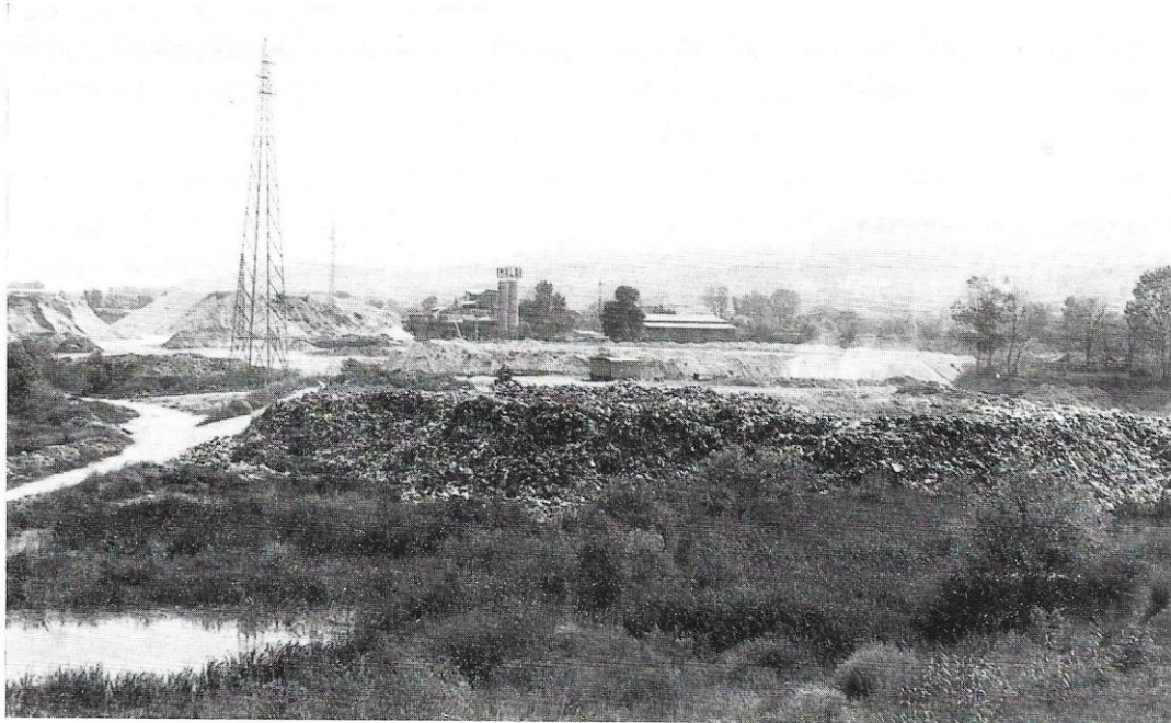
La discarica di rifiuti del Comune di Montesilvano, a ridosso del Saline. Alle Spalle, un'impresa di lavorazioni inerti.
