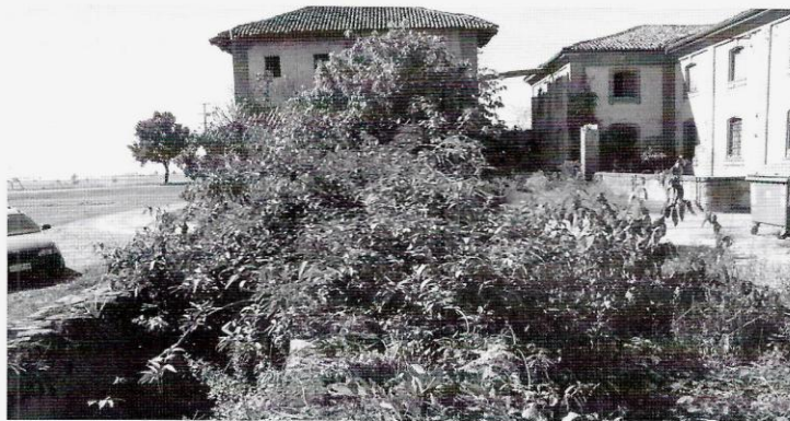
Fossi e fabbricati ormai in disuso.
