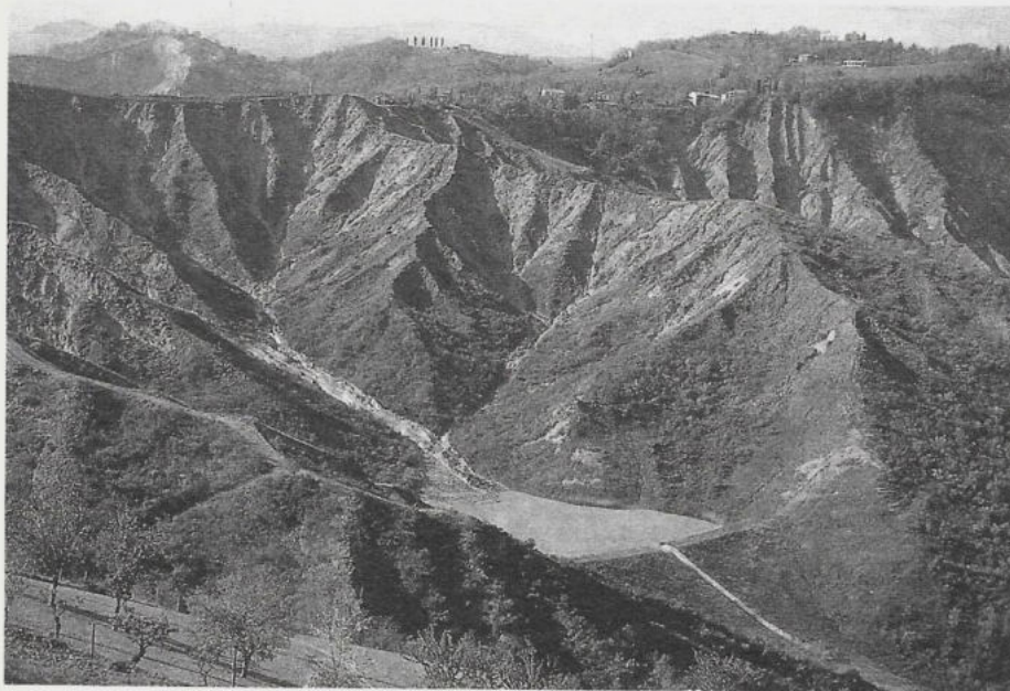
Fig. 2. «Briglia» in terra battuta realizzata dal Consorzio di bonifica «Reno-Palata» nell'anfiteatro calanchivo «Rio dei Rii», a monte della città di Bologna (loc. Sabbiuno). Attualmente la colmata di monte è già completata e svolge egregiamente le sue funzioni di consolidamento e di supporto alla espansione della vegetazione spontanea, senza alterare le caratteristiche salienti del Calanco.
