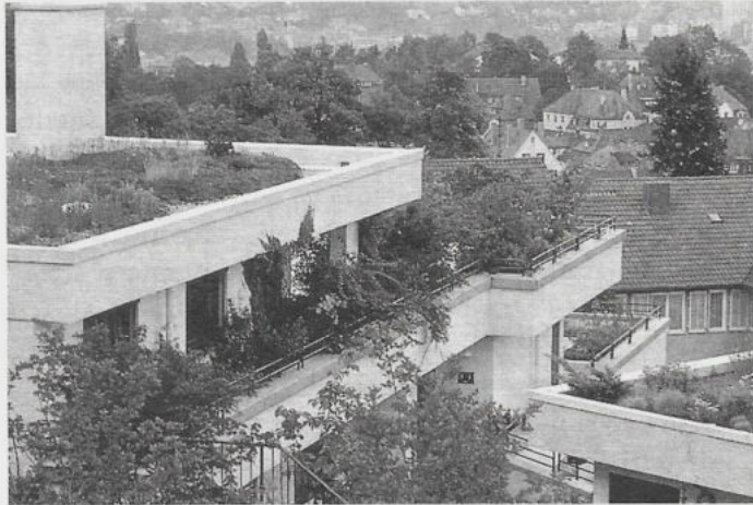
Fig. 9. Stoccarda. Complesso residenziale «Tazzelwurm»: verde intensivo ed estensivo. Superficie 1480 m 2 .
