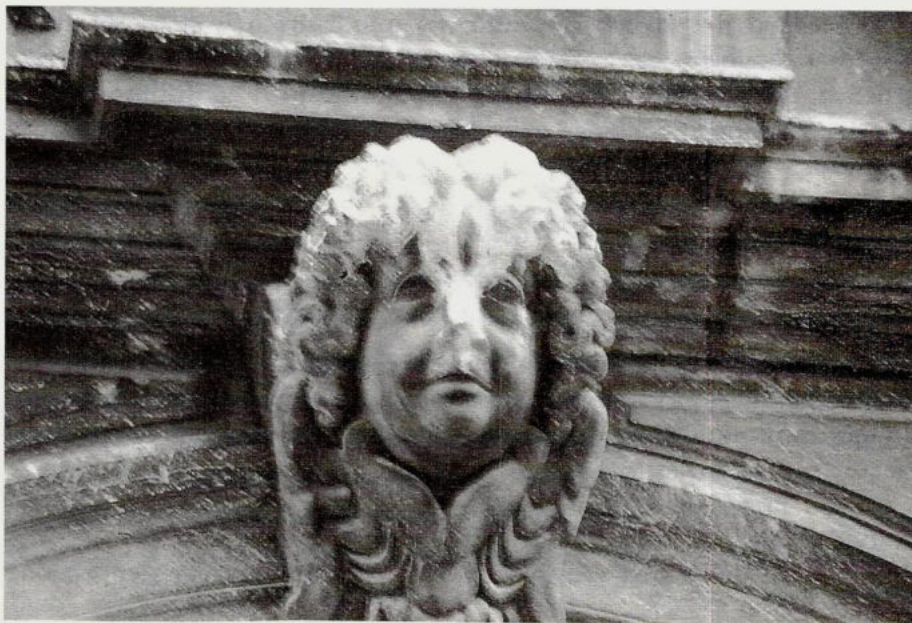
Fig. 1. Esempio tipico di aree nere e bianche su un monumento in pietra.
