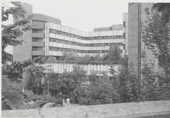
Fig. 1. Monaco di Baviera - Ospedale Munchen Bogenhansen. Superficie giardini pensili 10.000 m 2 . Verde intensivo. Spessore substrato cm 15+40.
