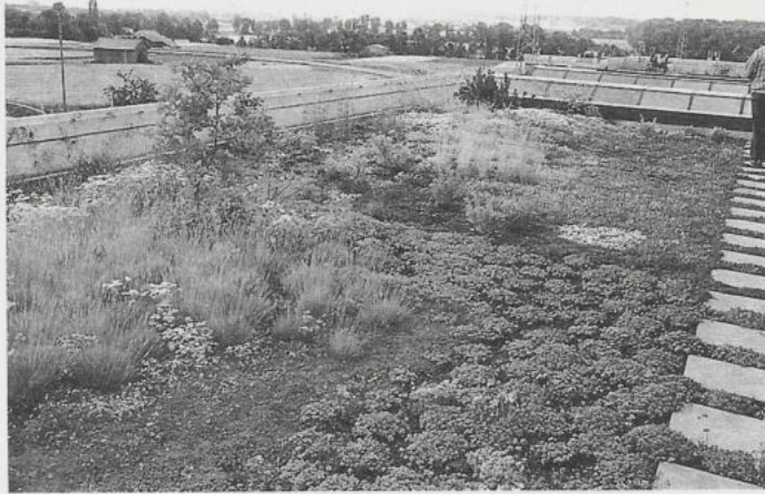
Fig. 8. Una sistemazione a verde estensivo con prevalenza di Sedum .
