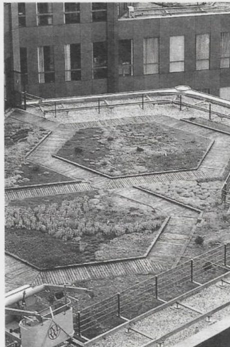
Fig. 7. Università di Monaco. Sistemazione di tetto a verde estensivo.
