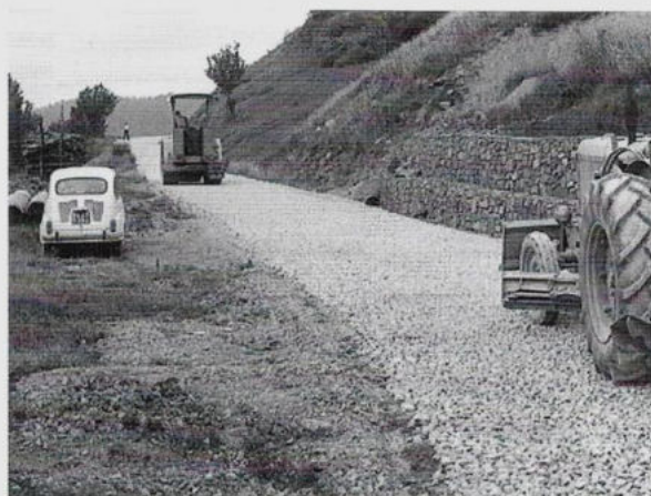
Figura 2 - Nel secondo dopoguerra, si è dato un forte impulso alla costruzione di infrastrutture viarie al fine di limitare l’isolamento della montagna e favorire il trasporto del latte verso i caseifici
