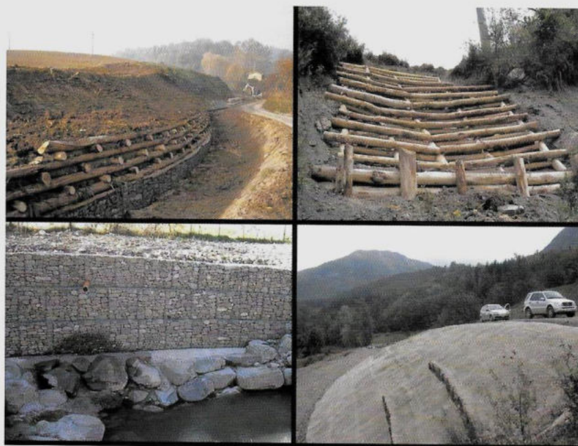
Figura 8 - Alcune opere di difesa: come si può vedere nelle immagini, si privilegia l'uso di legname e pietrame reperito in loco
