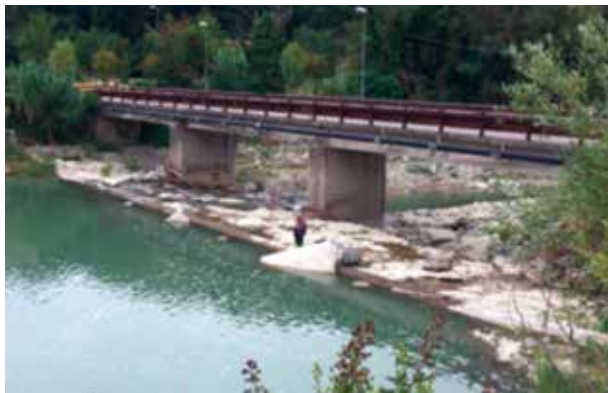
Fig. 20 – Il ponte di Rineggio sul Santerno a Borgo Tossignano sommerso e danneggiato dall'alluvione del 2014 per la luce insufficiente, ma riadattato senza alcuna vergogna per il pericolo che costituisce (Vai 2014).
