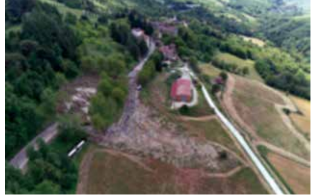
Fig. 18 – Frana di Piancaldoli (v. testo per spiegazione) (Foto A. Gardenghi).
