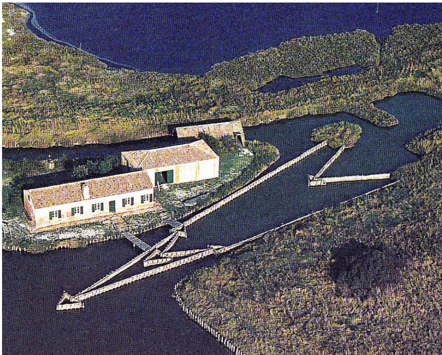
Moderno lavoriero in cemento.
