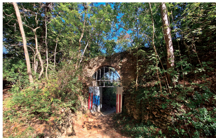
Fig. 5 - Il ponte-acquedotto, che scavalca il sentiero conducente a Monte Mario e Battedizzo, costituisce l'unico elemento architettonico visibile del sistema idraulico della Villa la Quiete.
