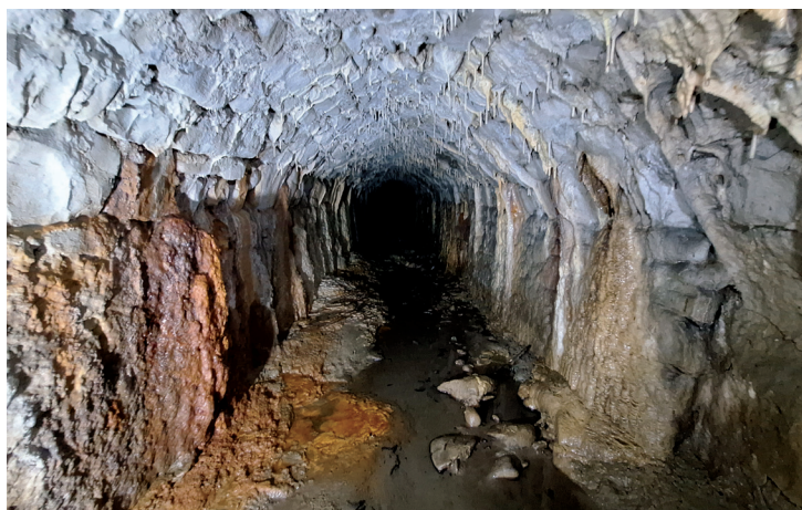
Fig. 7 - Il traforo presso il torrente Olivetta è un'opera idraulica legata alla regimazione di un piccolo corso d'acqua. Buona parte del manufatto è rivestita con blocchi di pietra locale.
