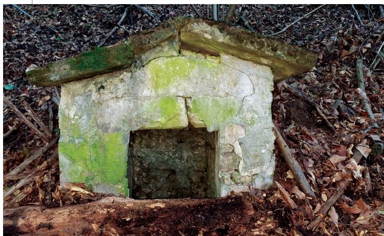
Fig. 4 - L'opera di presa dell'acquedotto, sotto Monte Mario.
