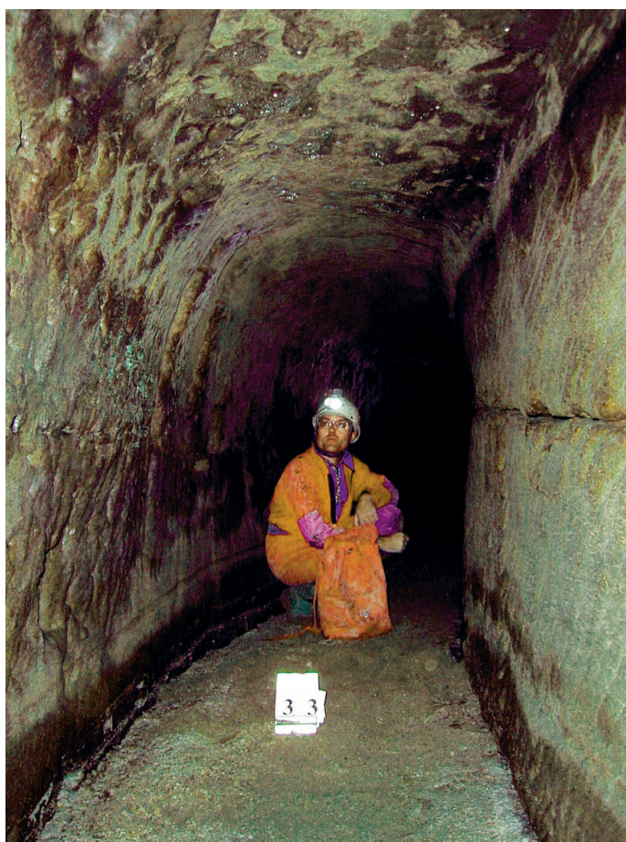
Fig. 3 - Un aspetto del cunicolo romano di età augustea, riutilizzato a fine Ottocento per veicolare acqua al Mulino d'Albano. È da evidenziare la perfetta conservazione dello scavo in arenaria dopo oltre 2000 anni dalla sua realizzazione.
