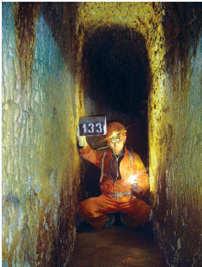
Fig. 1 - Una tipica sezione del cunicolo romano nel suo tratto di attraversamento delle arenarie plioceniche. Lo speco è in nuda roccia, rivestita spesso nel corso del tempo da un diffuso concrezionamento.
